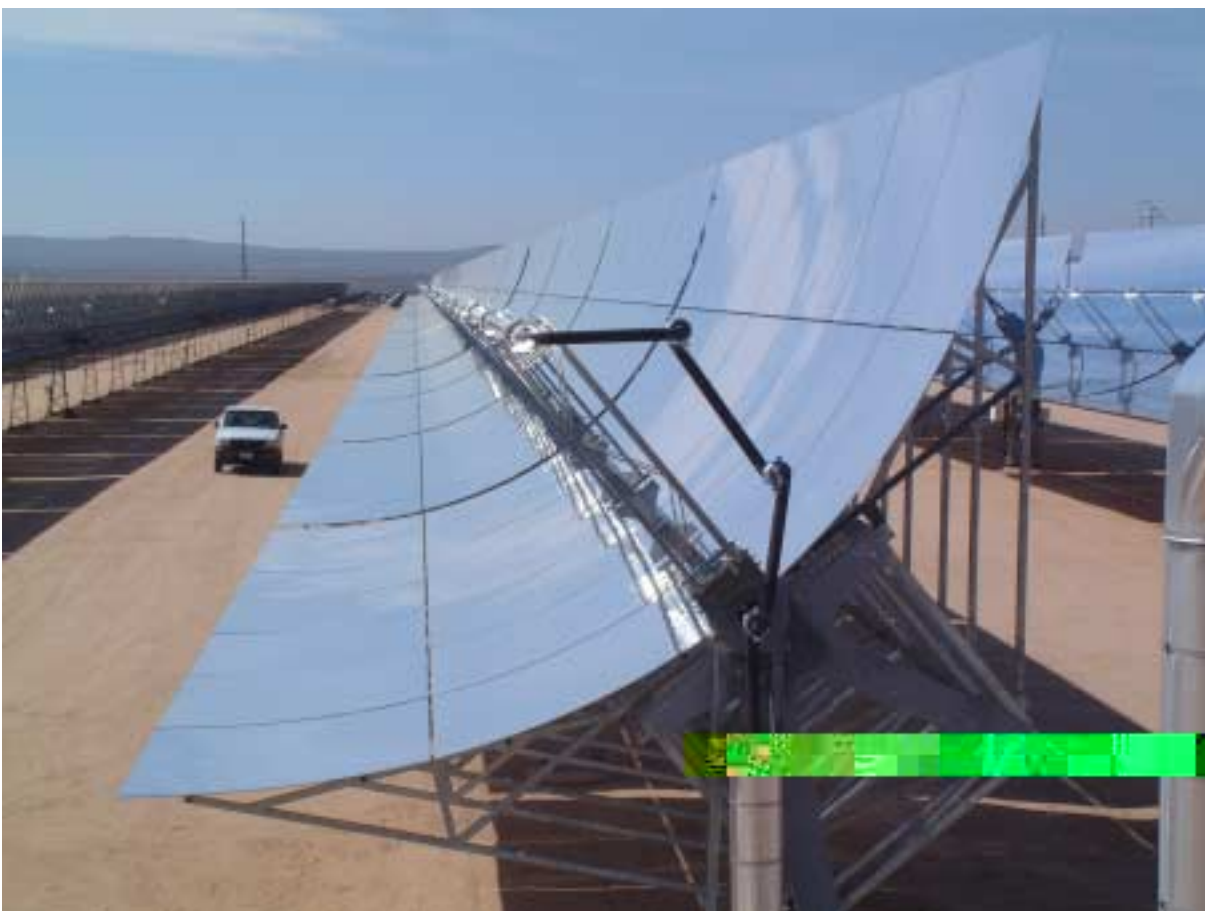
In Kalifornien von Solar Millennium AG mit Förderung des Bundesumweltministeriums errichtete Parabolrinne mit fortgeschrittenem SKAL-ET Design (Quelle: Solar Millennium AG, Erlangen)
