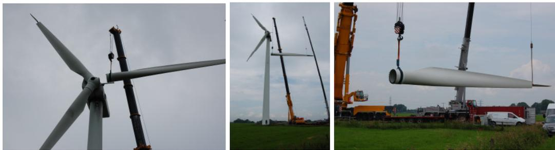
*Bild: Abbau von Nordex-Windenergieanlagen durch StiegeWind GmbH*
