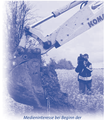
Medieninteresse bei Beginn der Bauarbeiten in Teterchen
