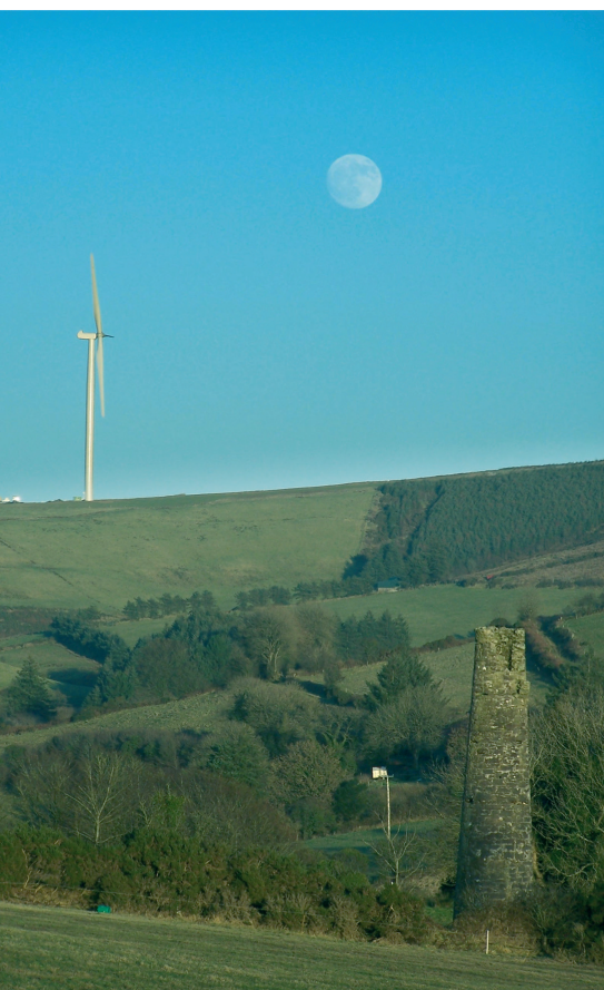
Im irischen Glenough ging im Juli 2011 der bislang größte von Abo Wind errichtete Windpark in Betrieb. Die 13 Nordex-Anlagen mit einer Kapazität von insgesamt 32.5 Megawatt gehören zum Portfolio der Abo Invest AG.
